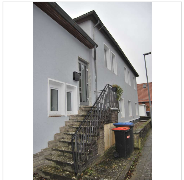
Eingang Wohnung 1. OG
