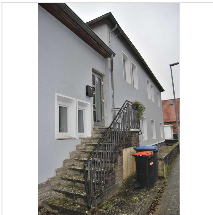
Eingang Wohnung 1. OG
